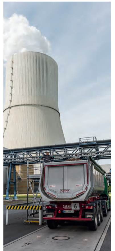
Sowohl in Braun- als auch in Steinkohlekraftwerken kann Klärschlamm in mechanisch entwässerter, teilgetrockneter oder vollgetrockneter Form mitverbrannt werden.
