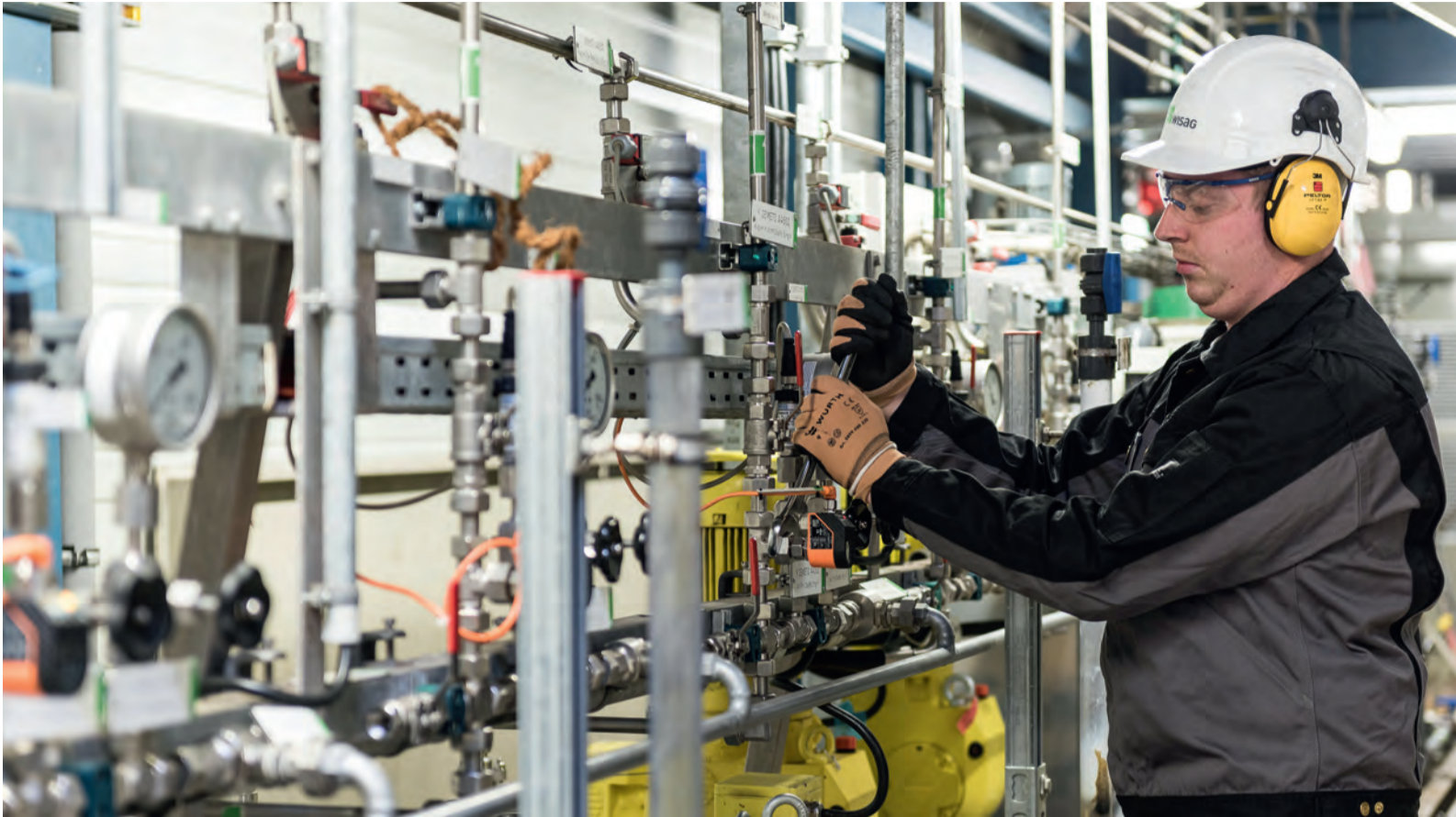
„Alles aus einer Hand“ - das bietet Wisag Industrie Service und übernimmt für Vattenfall die Betriebsführung in drei Mitverbrennungsanlagen für Sekundärbrennstoffe und Klärschlamm. Bilder: Wisag
